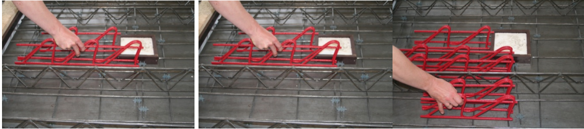
Rysunek 3: Montaż zbrożenia typu FDB
