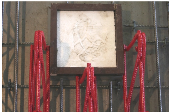
Rysunek 2: Montaż zbrojenia FDB bezpośrednio przy krawędzi słupa
